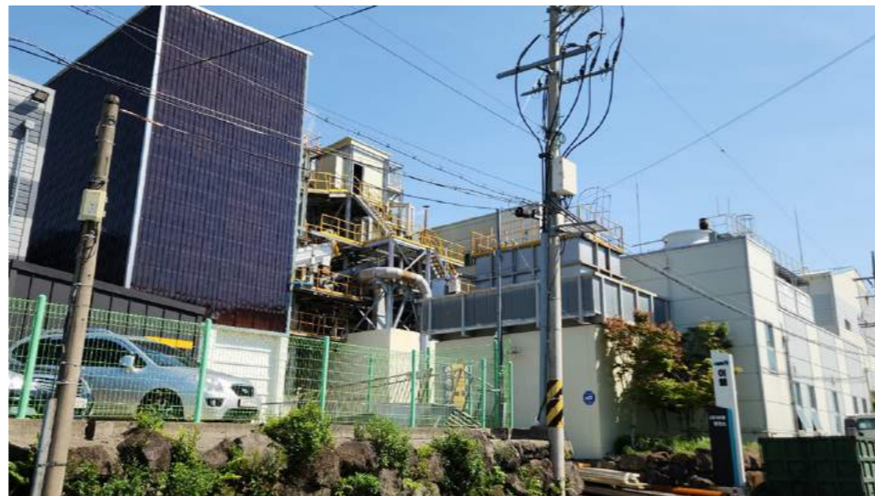
산업용 보일러 등 이웰 Bio-SRF 발전설비
